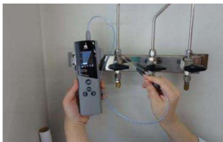
打开电源，将探针置于要进行气体泄漏检查的位置
